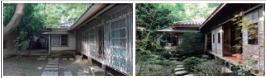
図 9. 日本家屋の修復前（左）と修復後（右）の様子
